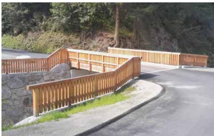
Diesen Sommer wurden im Bereich der Geiselhöfe in Tux-Vorderlanersbach die beiden Brücken über den Bangartbach und den Hobarbach erneuert.
